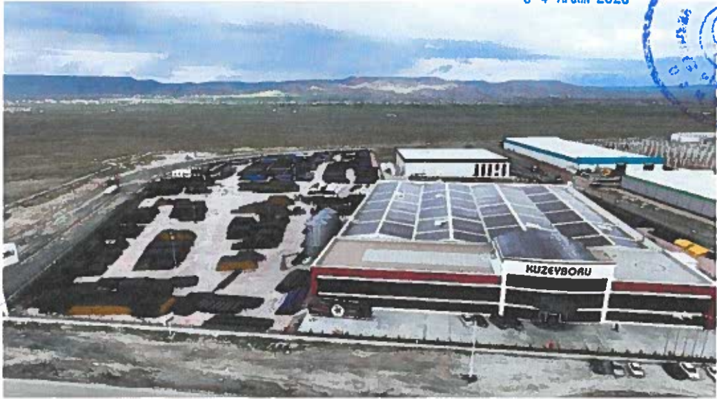
Resim 1: Kuzey Boru Merkez Fabrika Binası
