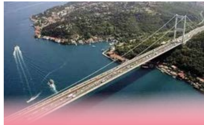
Köprülerin Alt Yapı Çalışmaları
