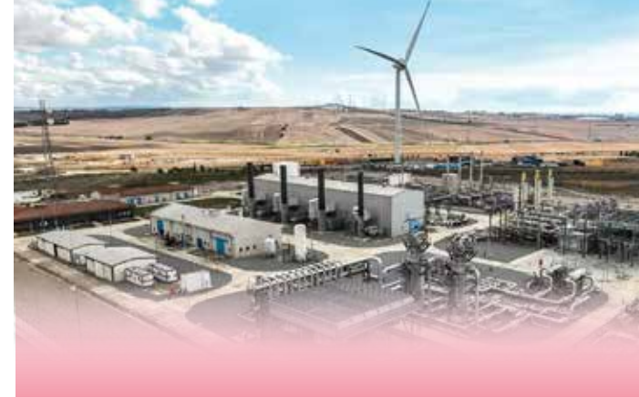
Doğalgaz Depolama Tesisleri
